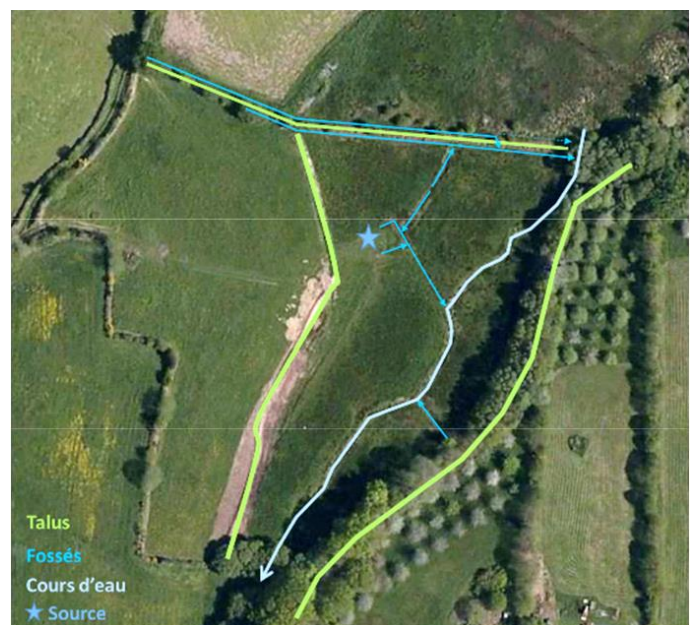
Figure 1 – Photographie aérienne de la parcelle avant les travaux © FMA
